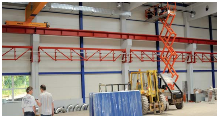
Nová hala. Uvnitř se již montují technologie.
