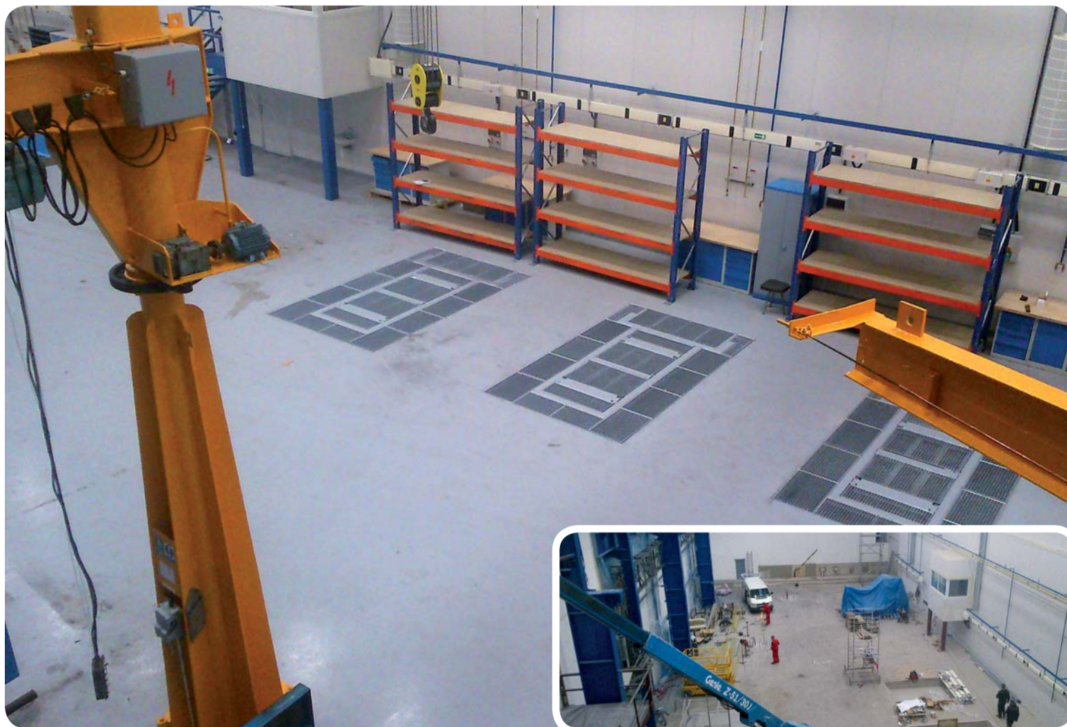
Motorárna je po rekonstrukci připravena na montáž technologií.
