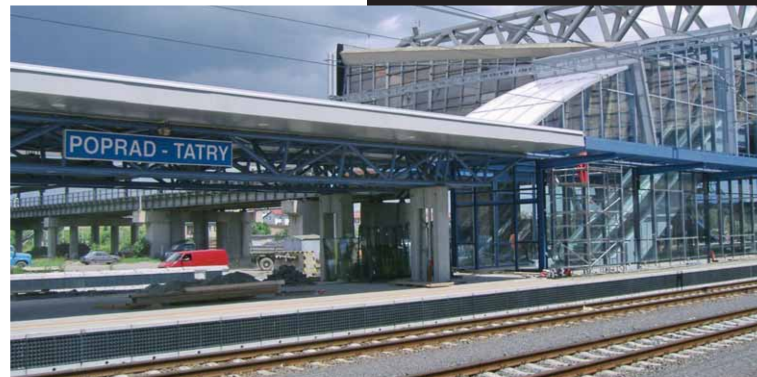
Pri rekonštrukcii Železničnej stanice Poprad-Tatry sa prostredníctvom nového konceptu mimoúrovňového križovania pešej komunikácie dosiahol architektonicky pôsobivé a maximálne funkčné prepojenie aj medzi dominantnou výpravňovou budovou stanice a prestupovou halou TEŽ. Rekonštrukciou prešli staničné kolaje a obidve zhlavia, pribudli tri nové zastrešené nástupištia, schodiská, eskalátory, osobné výťahy pre imobilných, podchod a ďalšie novinky.
