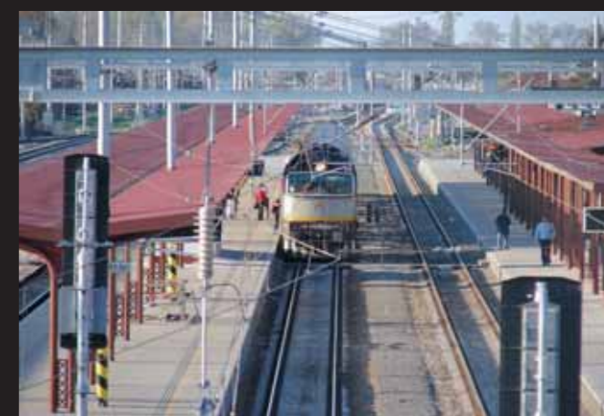
V Železničnej stanici Leopoldov už stavbári zahlásili hotovo.
