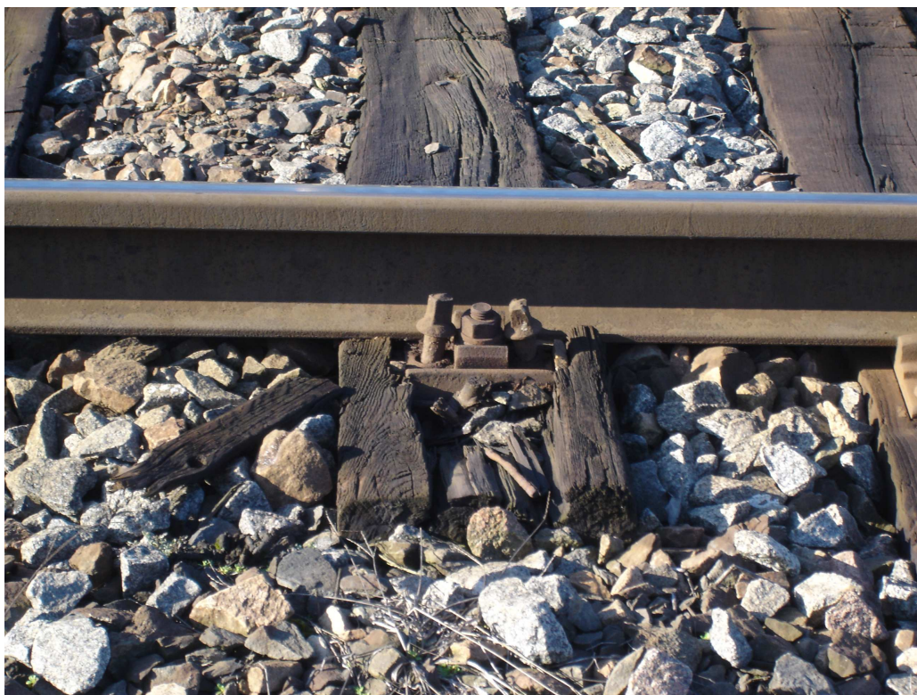
Obr.17 Uvolněné vrtule již neplní požadovanou funkci.
