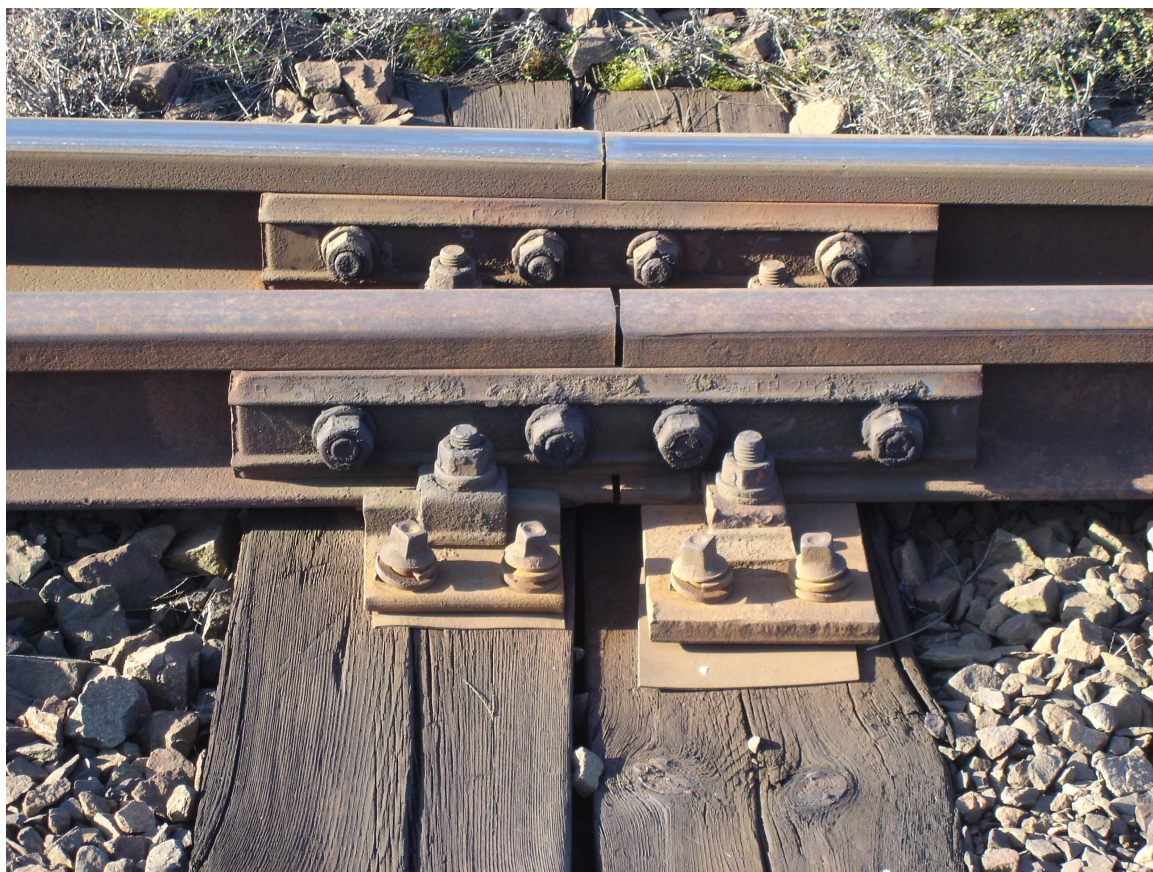
Obr.7 Detail styku kolejnic z vnitřní části
