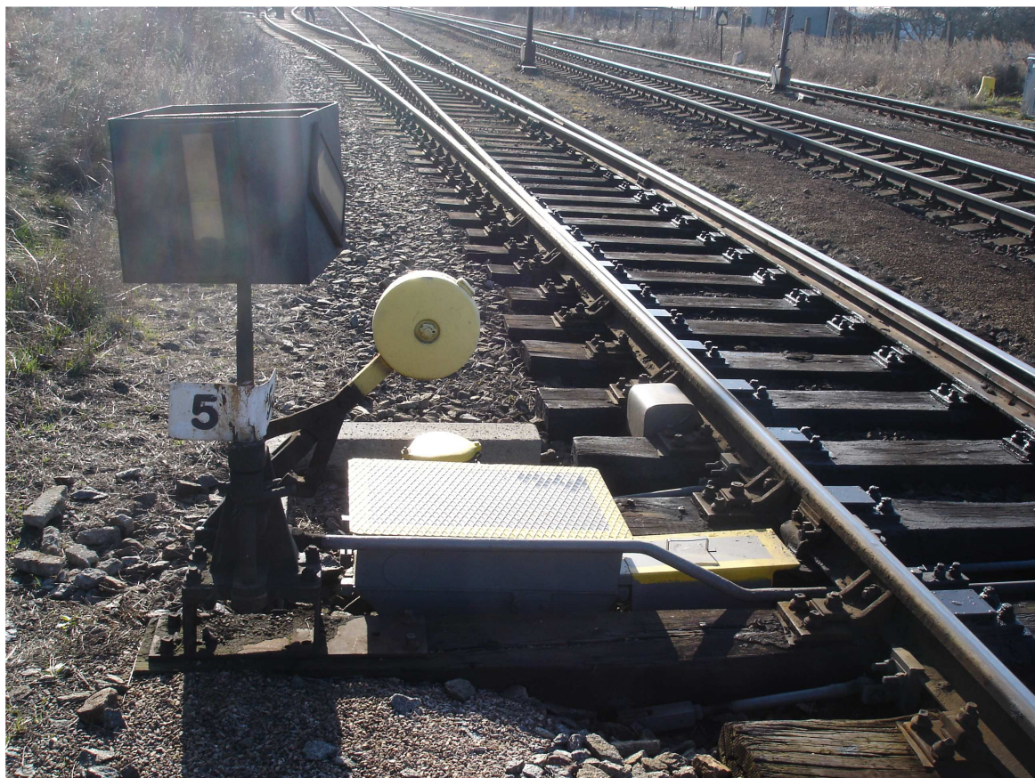
Obr.5 Zajištěná výhybka č. 5 umožňující přechod na manipulační kolej č. 4
