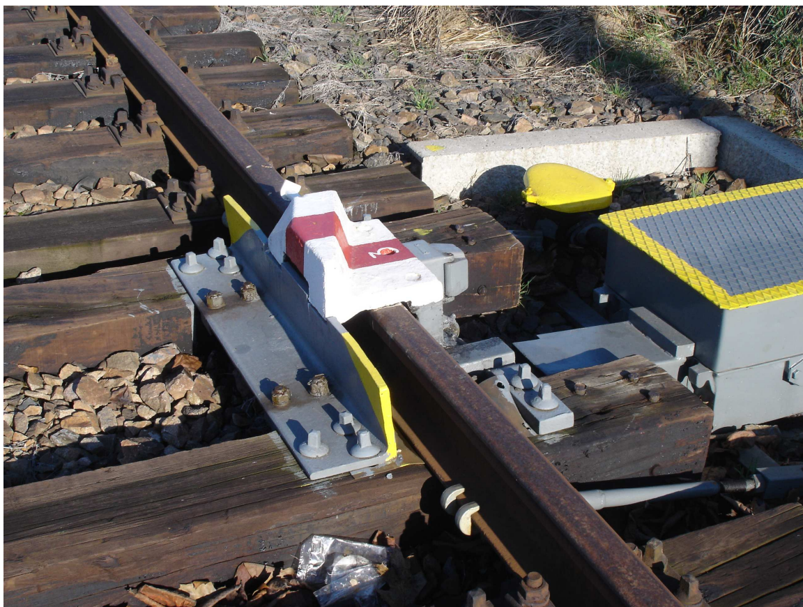
Obr.15 Výkolejka umístěná na manipulační koleji č. 4
