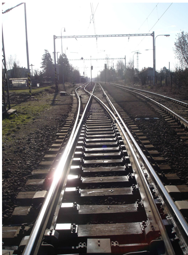
Obr.4 Pohled z koleje č. 1 u výhybky č. 6 směrem do stanice.
