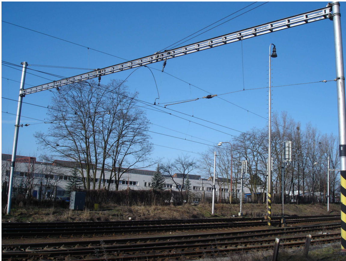
Obr.20 Upevnění trakčního vedení na konstrukci.
