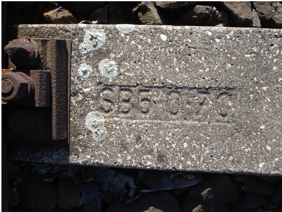
Obr.12 Způsob označení betonového pražce.
