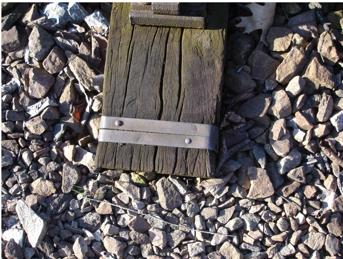
Obr.13 Detail možného způsobu zajištění pražce proti rozpadu.
