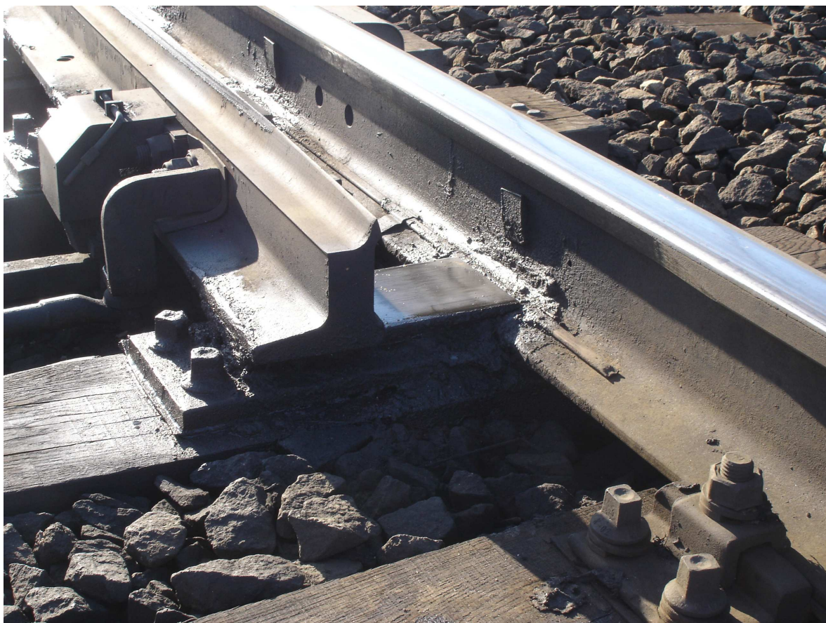
Obr.6 Detail kluzné stoličky napomáhající přechodu jazyka k opornici.
