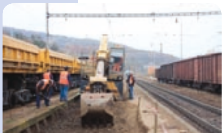
Kým prvú koľaj v objekte Železničnej stanice Slanec opravujú, na ostatných je normálna prevádzka.
