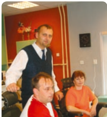
V objekte stavadla 3 obsluhujú nové zabezpečovacie zariadenie signalisti Gabriel Kalapoš a Judita Mészárosová. V strede - dozorca prevádzky pre riadenie dopravnej činnosti Ing. Zoltán Nagy.
