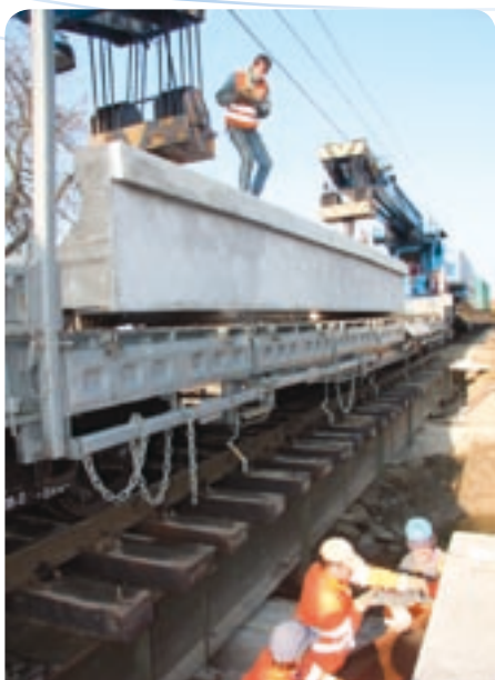
Posledné úpravy pred uložením železobetónových prefabrikátov.
