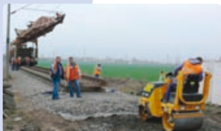
Martin Hložek, úsekový správca SMS ŽTS Šaľa (vpravo) a Štefan Fördös, zástupca zhotoviteľa Icores Slovakia s.r.o., pozorne sledujú činnosť vibračného valca pri zhutňovaní podkladu nového koľajového lôžka medzi kilometrami 2,650 až 3,200 trate Nové Zámky – Šurany.
