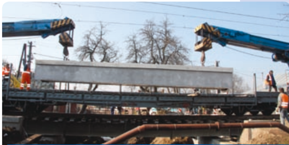
Dokonalá súhra obslúh žeriavov pri skladaní budúcich častí mosta fascinovala. Miestami to vyzeralo, akoby sa mostné prefabrikáty vznášali na krídlach vtákov.
