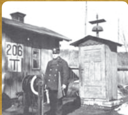
Zvonkové návěstidlo v samostatne stojacej drevenej búde bolo obvyklé pre trate StEG (z knihy Griebel, H.: ČSD-Dampflokotiven. Teil 1. Slezak, Wien 1969. str. 113).
