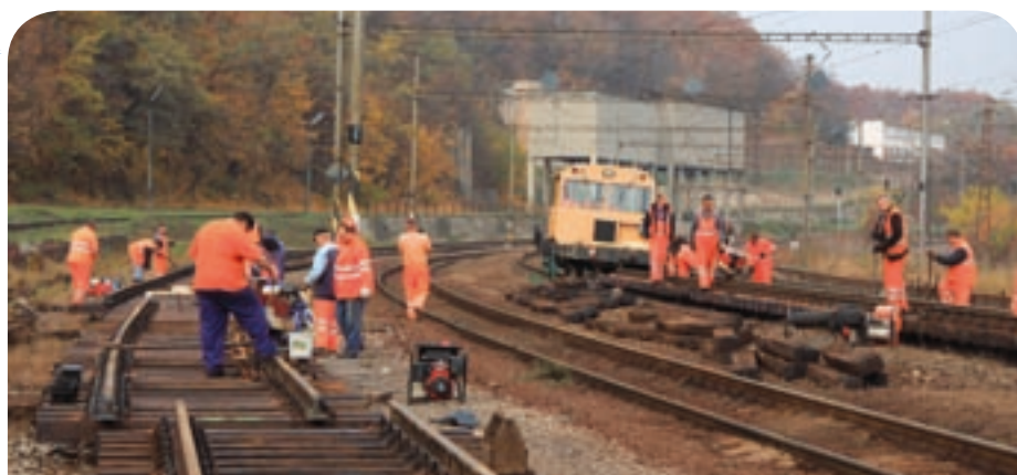
V priemere štyridsať zamestnancov TO Trebišov v úzkej spolupráci s MDS Trebišov zabezpečuje v Slanci výmenu 350 podvalov.
