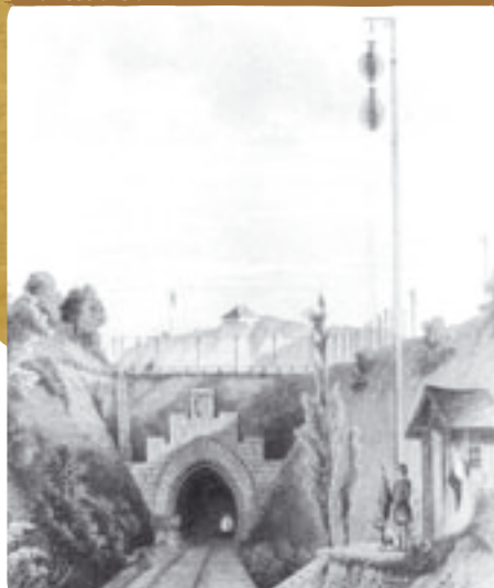
Bratislavský tunel a košové návěstidlo.
