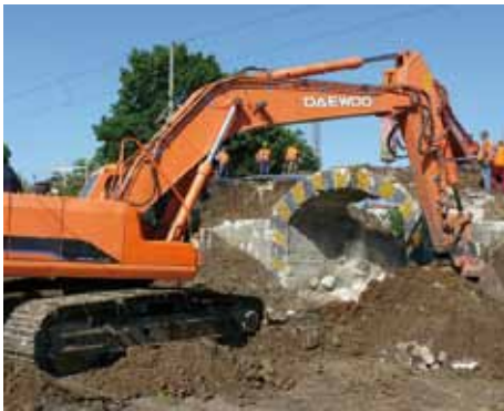
Dve demolačné rýpadlá sa zahryzli do konštrukcie kamenného mosta z roku 1880, aby sa za 14 hodín z neho stala len hromada sutiny.
