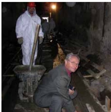
Rekonštrukcia prevádzky rozmrazovne v Čiernej nad Tisou bola častým návštevým miestom riaditeľa MO.
