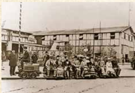
Súprava ťahaná prvým elektrickým rušňom zviezla 18 ľudí. Na berlínskej výstave sa pohybovala po 300 metrovom okruhu rýchlosťou 7 km/h.
