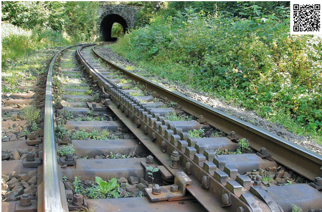
Začátek prvního ozubnicového úseku – detail, Tanvald, 8. 8. 2007, © Zbyněk Zlinský
