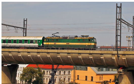
162.013 na estakádě hlavní nádraží, Nové spojení, Praha, 12. 9. 2008, © Jiří Řečka
