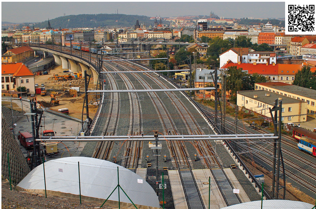
Estakáda hlavní nádraží, Nové spojení, Praha, 12. 9. 2008, © Jiří Řechka
