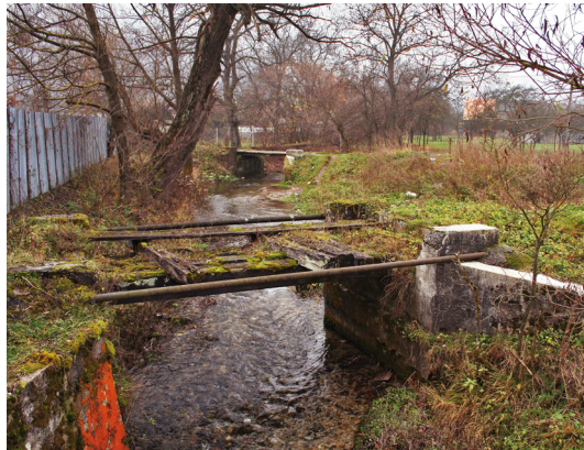
Drevená konštrukcia mostíka, Muráň, 15. 11. 2008, © Igor Molnár
