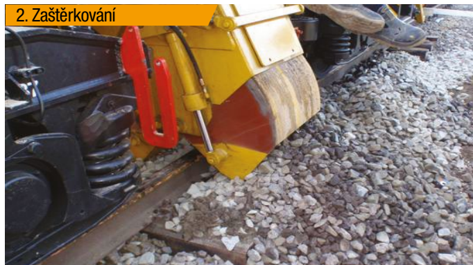
Cílené zašterkování podbíjených oblastí.
