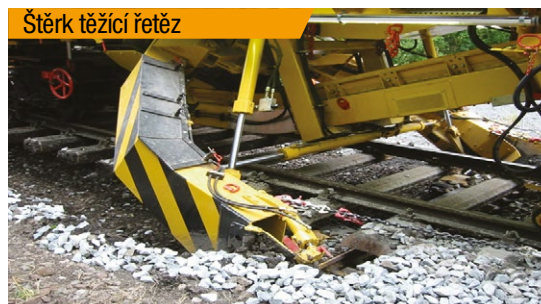
Distribuce materiálu pro založení první konstrukční vrstvy
