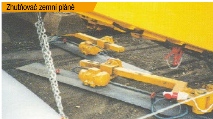
K optimálnímu zhutnění zemní pláně.
