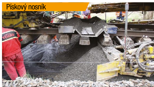
Rozvinutí geotextílie
