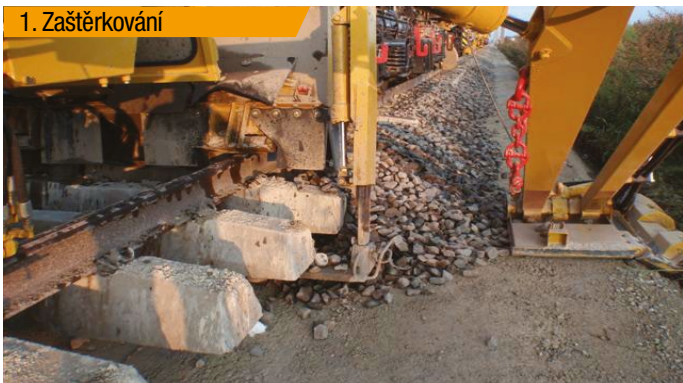
Přivezení a předpěchování (recyklovaného) šterku.
